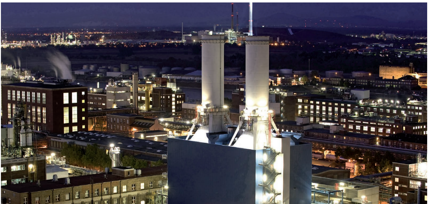
Generación eficiente de energía con plantas de cogeneración.
